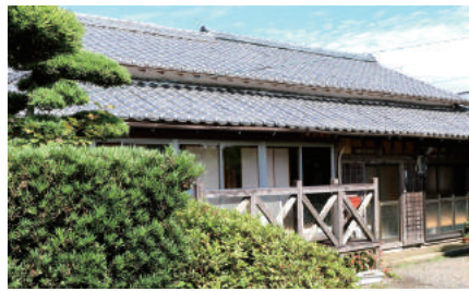
宿泊施設としてご利用いただく、古民家をリノベーションしたお試し住宅です。間取りが広いのでゆったりと過ごせます。
